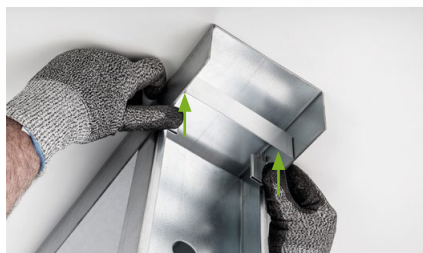
Abbildung 3: Gleitender Deckenanschluss
